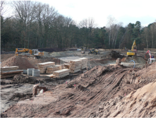
Bau der Außenanlagen der Delphin-Lagune des Nürnberger Tiergartens
