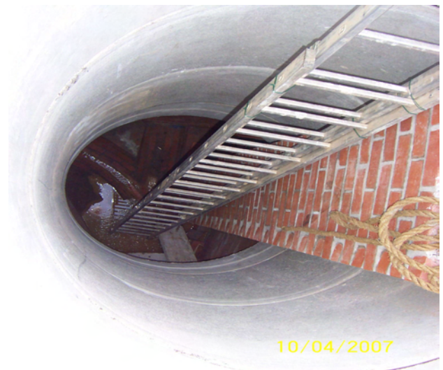
3. Bauabschnitt einer Entflechtungsstraße. Hier wurden Straßen-, Kanal- und Ingenieurbautätigkeiten ausgeschrieben.
