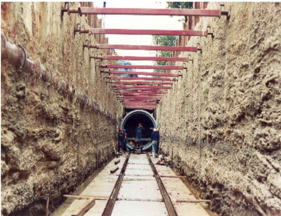
leubau eines Abwassersammlers, Betonrohre DN 2600 in einer wasserdichten Baugrube (Dichtwände); Düsseldorf 1999
