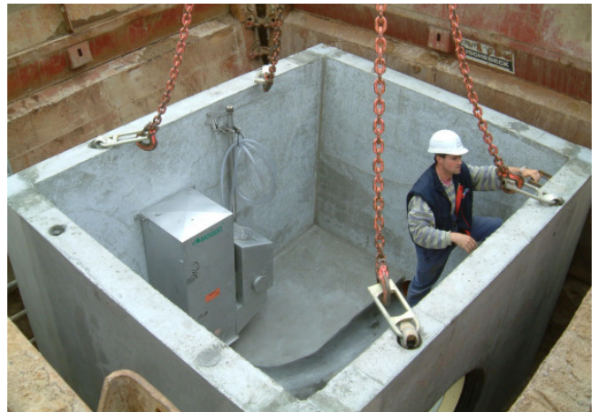
Drosselschacht Fritz-Reuter-Straße in Schwerin
