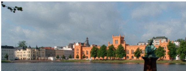
Ufersicherung Pfaffenteich, Schwerin
