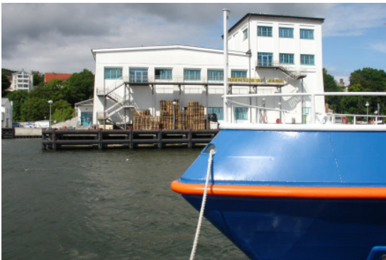
Rekonstruktion Kühlhaus Sassnitz
