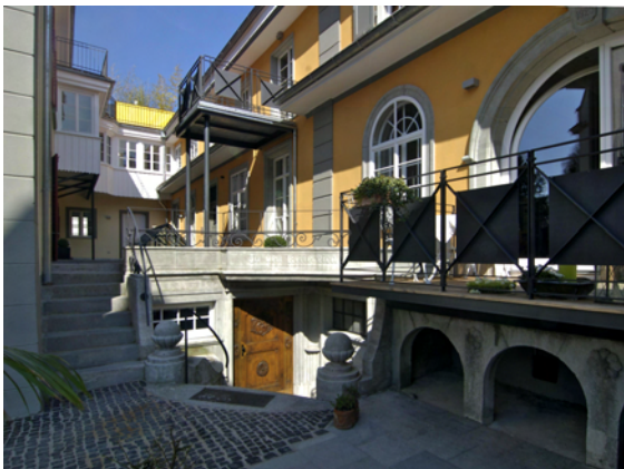
Umbau, Ausbau und Komplettsanierung einer Untermehrvilla, Konstanz
