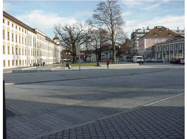
Umbau des Residenzplatzes
