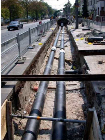
Fernwärmenetz in Ludwigshafen
