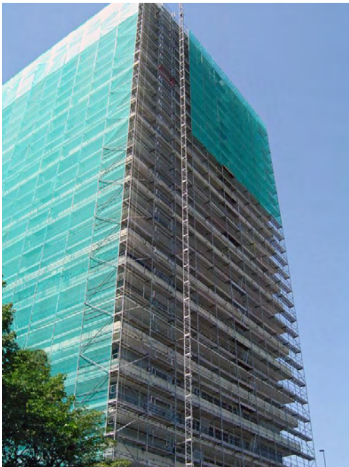
Fassaden- und Balkonsanierung Wohnhochhaus „Zollhofstraße“ in Ludwigshafen
