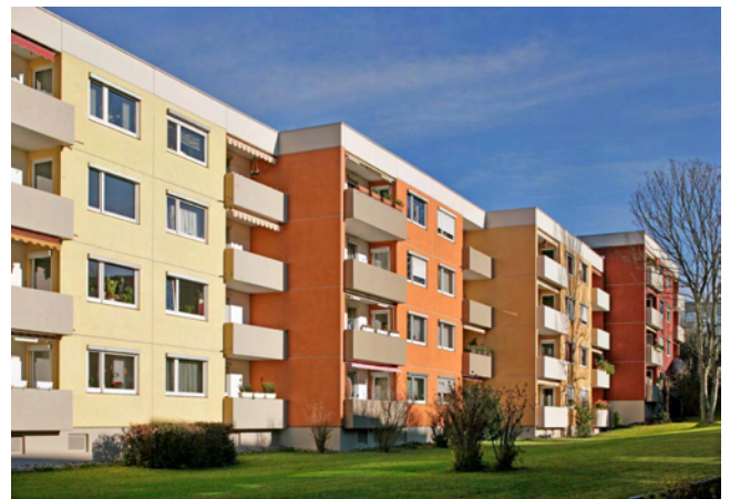
Sanierung der Wohnanlage „Posenerstraße“ in Sindelfingen
