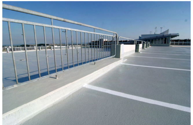
Sanierung Parkhaus „P10“ am Flughafen Stuttgart
