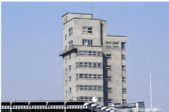
Betonfassadensanierung am Tagblattturm in Stuttgart
